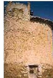
El interior de la torre palomar disponía de un original ingenio con un eje o árbol de madera, giratorio que facilitaba, por medio de tres pisos de madera y una escalera, el acceso a todos los nidos. El paramento de la torre contiene 25 filas de 60 nidos cada una, cada 5 filas hay un pequeño saliente para que las personas puedan ponerse de pie. Una ventana y una lucana son las únicas aberturas que permiten entrar el aire y la luz, un agujero con pendiente en el muro permitía extraer el guano.
